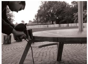
Verwenden Sie Scheuerpapier mit Körnung 80 und beginnen Sie auf der senkrechten Seite der Tischplatte. Halten Sie die Maschine parallel zum Tischrand. Scheuern Sie leicht, bis der Rand wieder gleichmäßig glatt ist.
